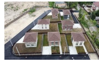
▲完成した7戸の木造住宅
