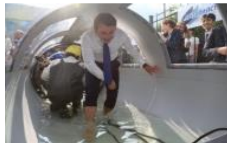
▲ Восстановление канализационных трубопроводов
